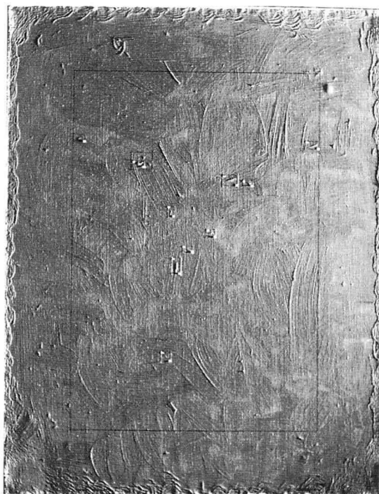
Figure 12 Photo en lumière rasante de l'éprouvette D. La densité de craquelures D_{craq} = 0,92\% après 167 jours de vieillissement hygrométrique.
